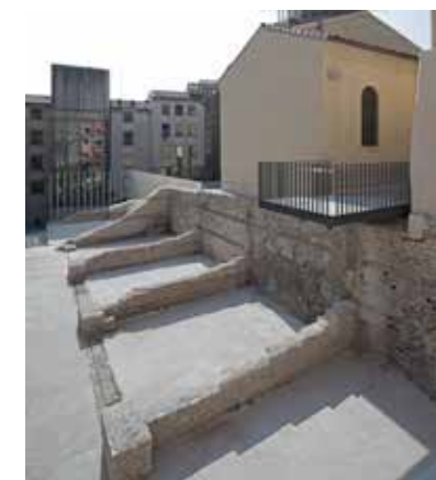
Principij nakon radova obnove
